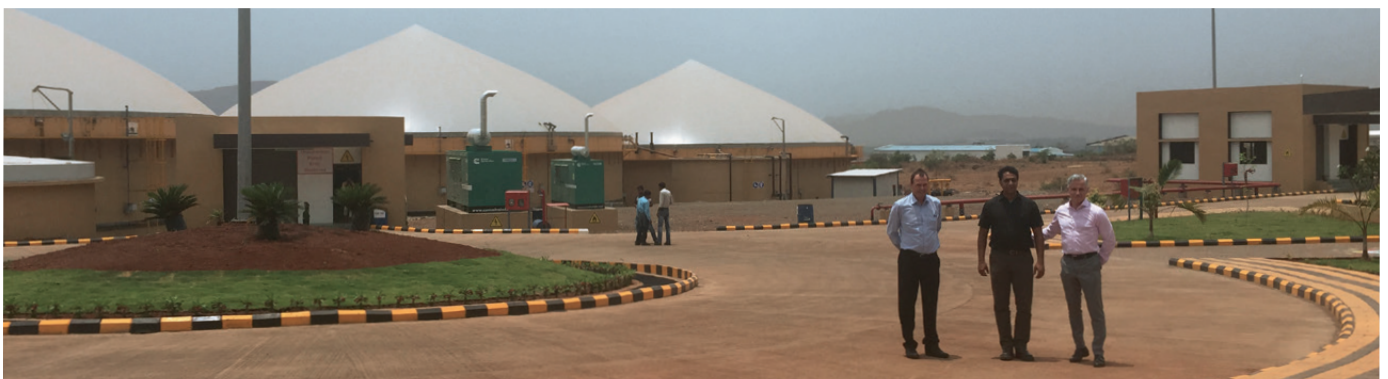
Stefan Hacker (Geschäftsführer BAUER KOMPRESSOREN), Smedh Bapat (Technischer Direktor NEX), Philipp Bayat (Vorsitzender der Geschäftsführung BAUER GROUP) (v.l.n.r.) vor der modernen Biogasanlage in Talegaon
